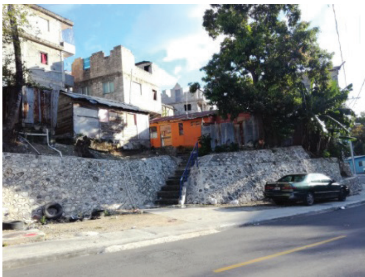
Imagen n°5 Fotos tomadas durante y después del saneamiento de la cañada Guajimía. © 2016-2018 DSV.
